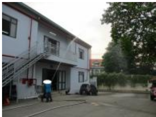
Test fire pump.JPG
